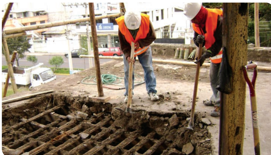
Casa Aranjuez. Retiro de elementos en estado de pudrición en la losa. Fuente: Ministerio Coordinador de Patrimonio.
